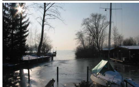
Hafenanlage und Boots- plätze müssen aufwändig gepflegt und unterhalten werden.
